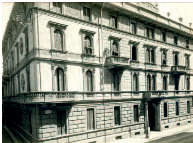
Milano. Palazzo Torrani, prima sede della Presidenza dell'Associazione. Sulla facciata dell'ultimo piano sono riportate la granate dei reggimenti
