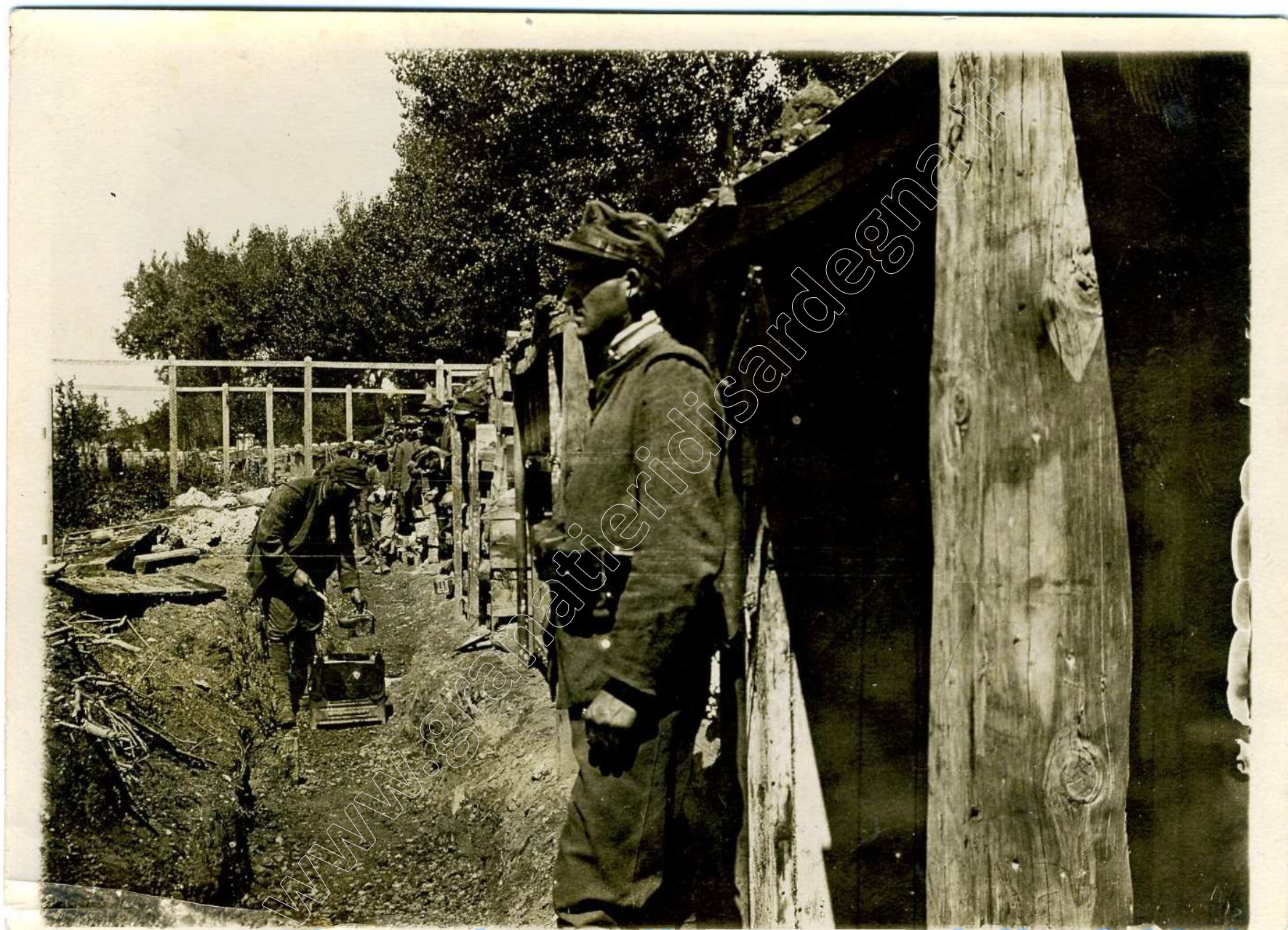
1915. La trincea lungo il muretto della fabbrica Adiawerke di Monfalcone.
