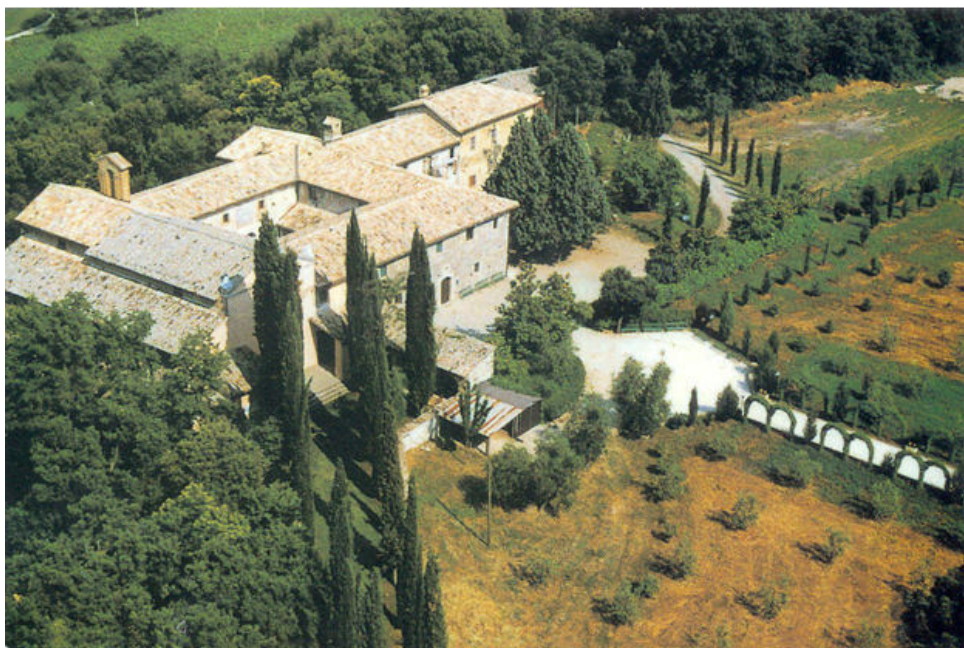
Veduta aerea del Convento di San Crispino
